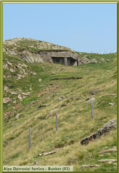
Alpe Davrosio: fortino - Bunker (02)
