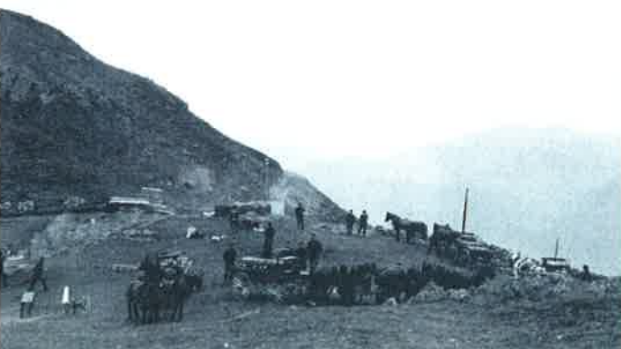
Truppa addetta alla costruzione dei forti sui monti di Medeglia.
